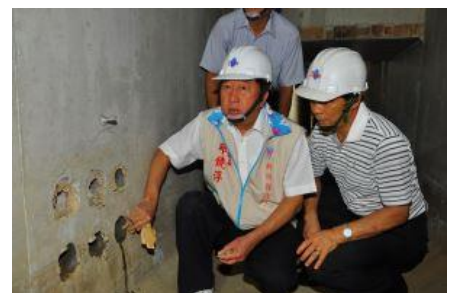
公共設施管線工程
