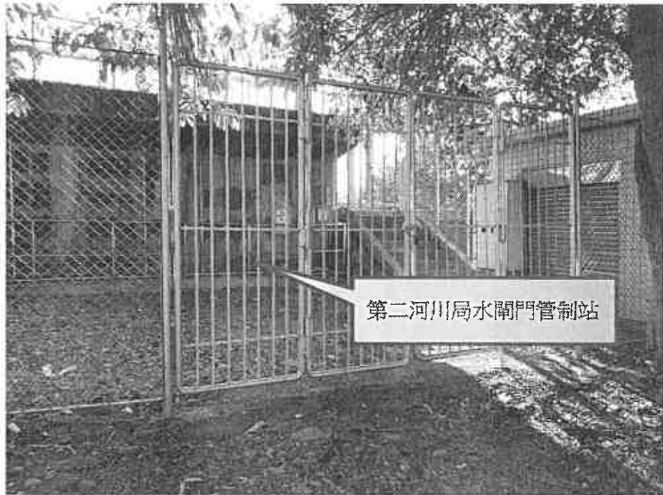
圖 2.4.2-4 第二河川局水閘門管制站與北向匝道位置衝突
