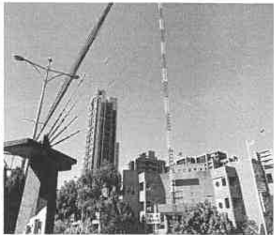
圖 2.4.1-2 警廣電臺天線固定鋼索
