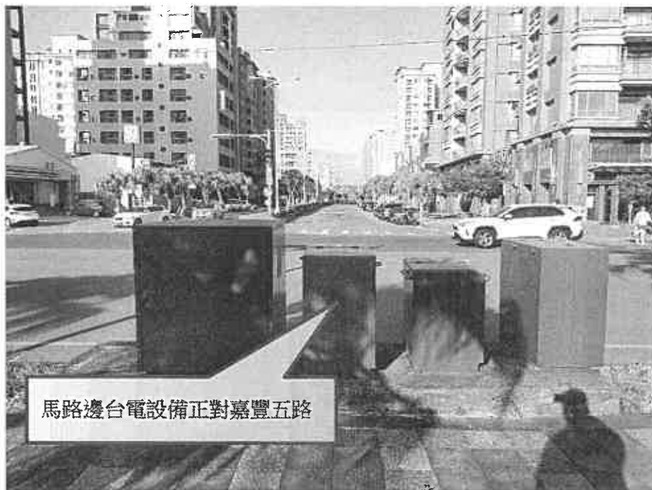
圖 2.4.2-3 經國大橋興隆路匝道出口與台電設備位置衝突
