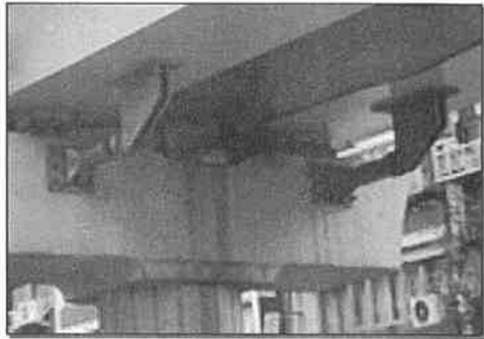
圖 5.2.6-2 能量分散阻尼器
