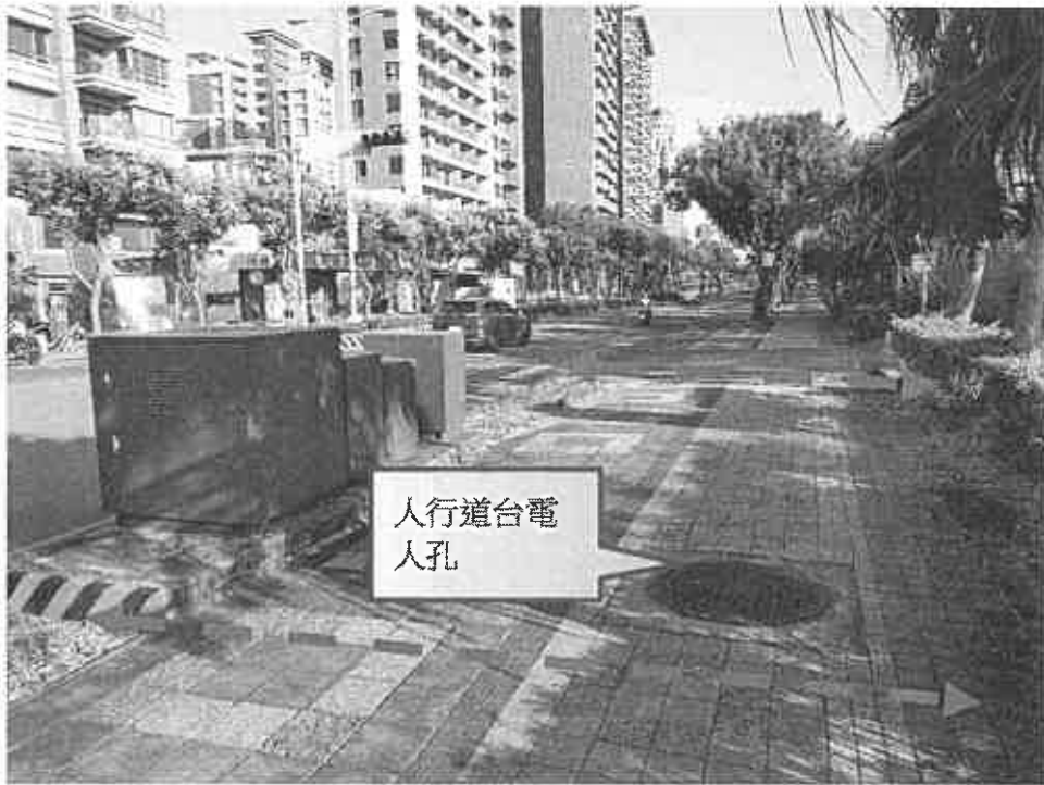
圖 2.4.2-2 經國大橋興隆路匝道出口與台電設備位置衝突
