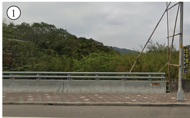
關西二號大橋
