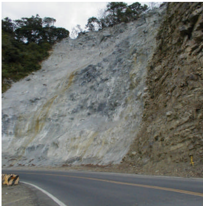
照片四 新中橫噴漿工法現況
