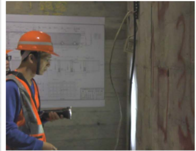
橋梁定期監測
