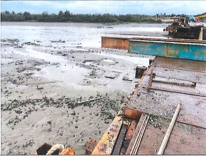
說明：工程目前停工狀態，復工後加速清除河道內掉落物。 日期：110/12/27
