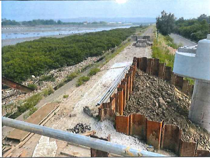
說明：橋墩目前待二河局核可後，將進行灌漿，期間如遇大雨請用塑膠布或稻草蓆減緩土砂流失。 日期：110/9/1
