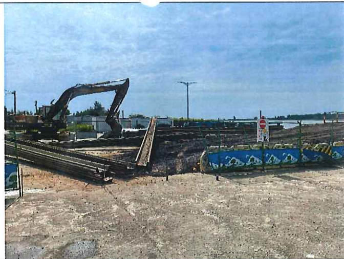
說明：工程機具及材料統一堆放 日期：110/06/01
