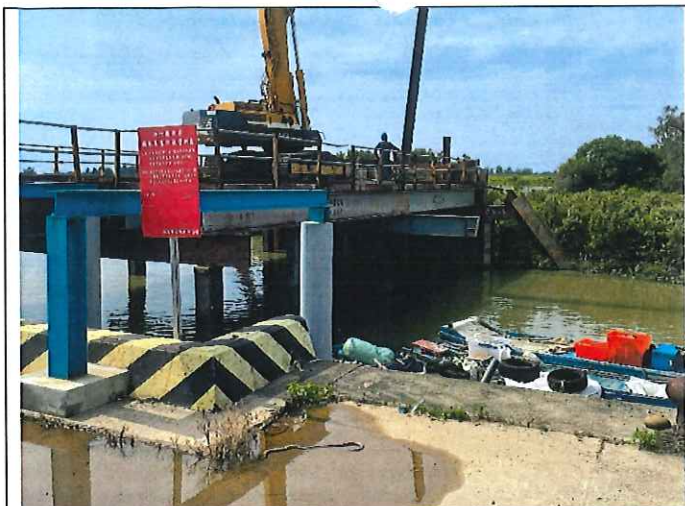
說明：目前採圍籬打樁，不清除紅樹林。 日期：110/06/01
