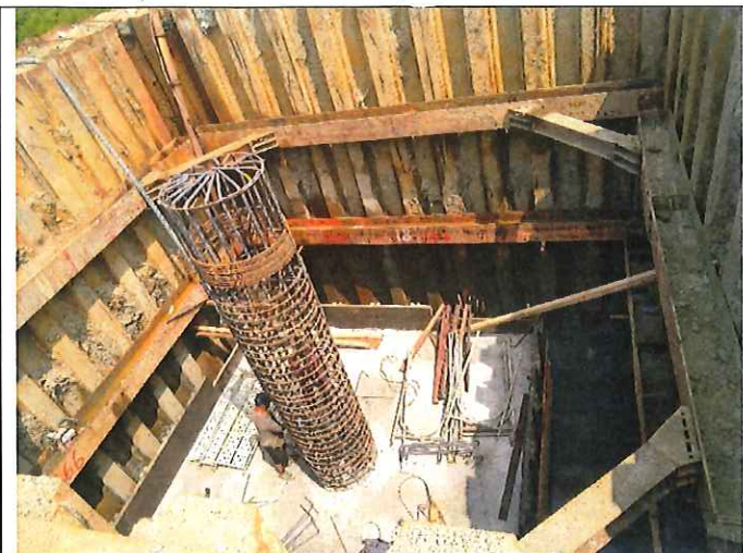
說明：橋墩施工中。 日期：110/9/1
