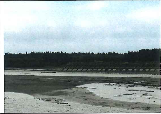
說明：鳳山溪右岸現況 日期：109/11/6
