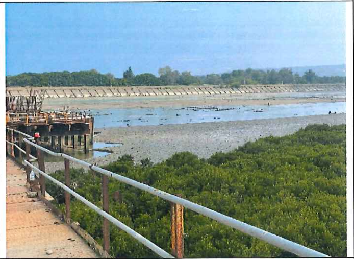
說明：施工未影響漁民作業 日期：110/9/1
