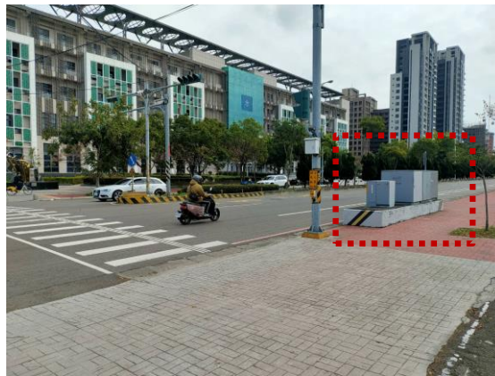
莊敬南路變電箱現況照片
