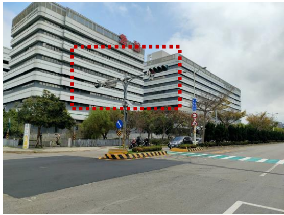
監視設備現況照片
