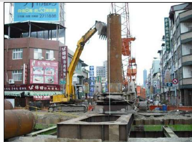
全套管基樁工法
