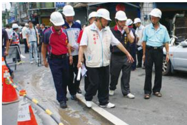
污水下水道工程視察
