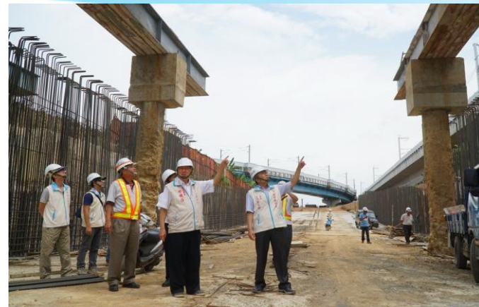
高鐵橋下聯絡道路工程視察
