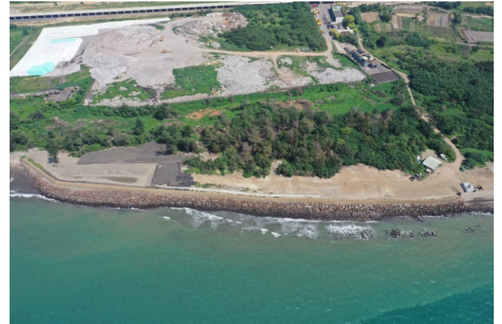
新豐海岸線有害廢棄物移除
