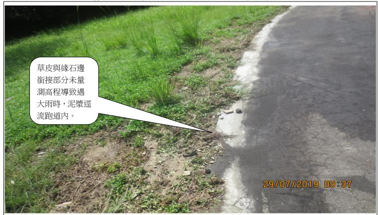
說明 草皮與緣石邊銜接部分未量測高程導致遇大雨時,泥漿逕流跑道內。
