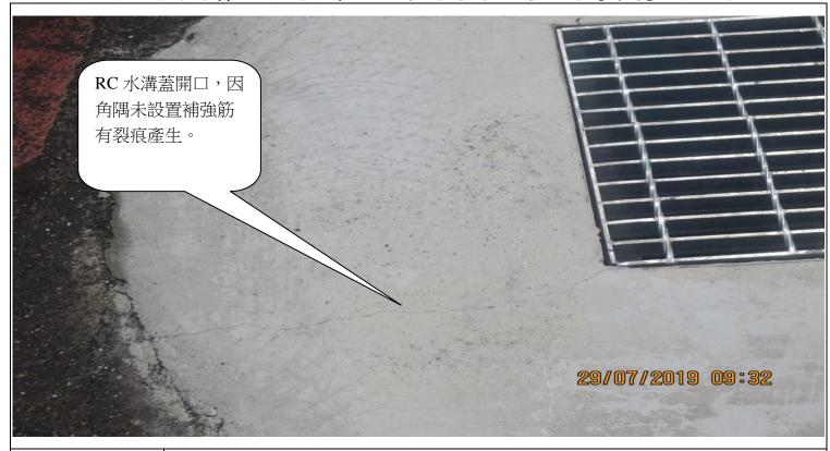
說明RC水溝蓋開口,因角隅未設置補強筋有裂痕產生。
