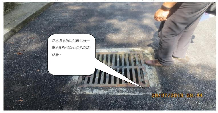
說明 原水溝蓋板已生鏽且有一處與鄰接地面有高低差請改善。
