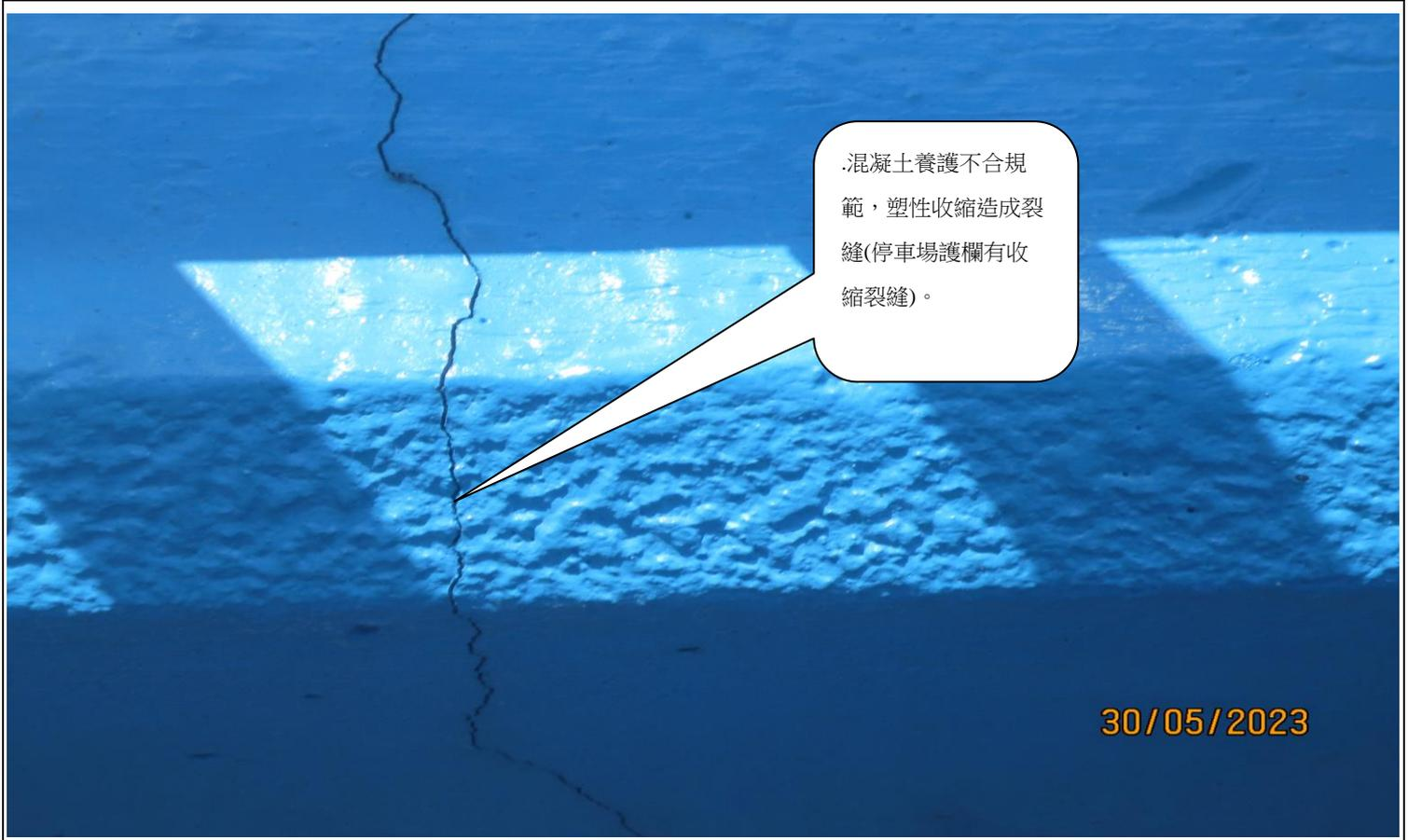
混凝土養護不合規範，塑性收縮造成裂縫(停車場護欄有收縮裂縫)。
