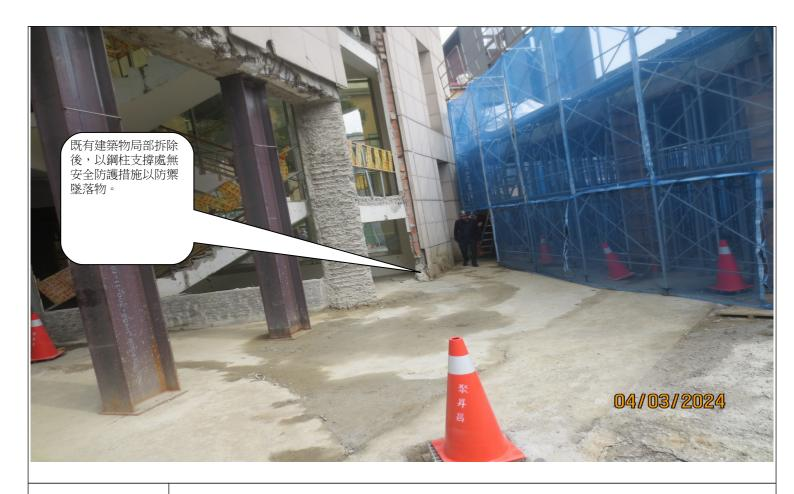
說明既有建築物局部拆除後,以鋼柱支撐處無安全防護措施以防禦墜落物。
