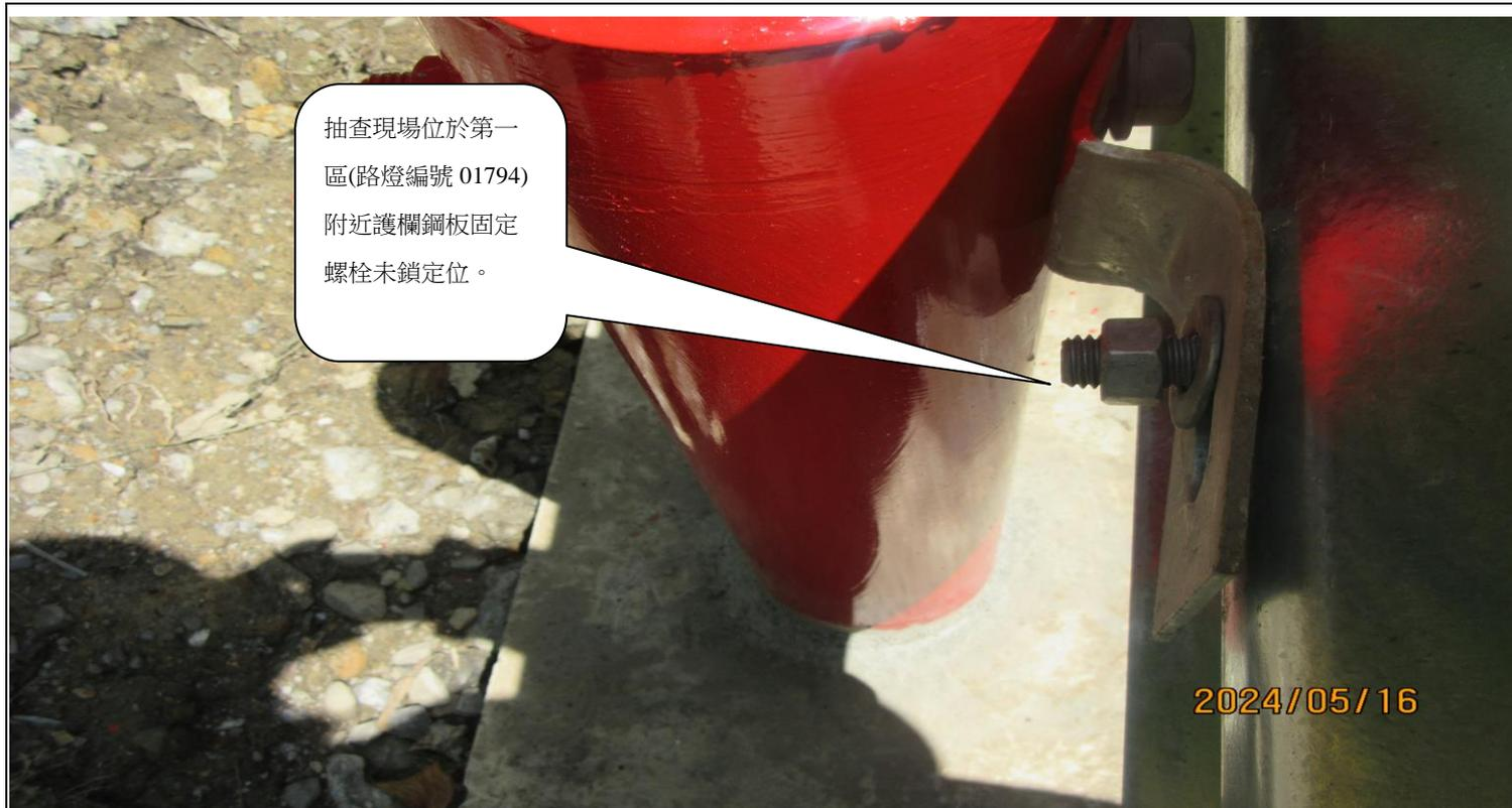
抽查現場位於第一區(路燈編號 01794)附近護欄鋼板固定螺栓未鎖定位。
