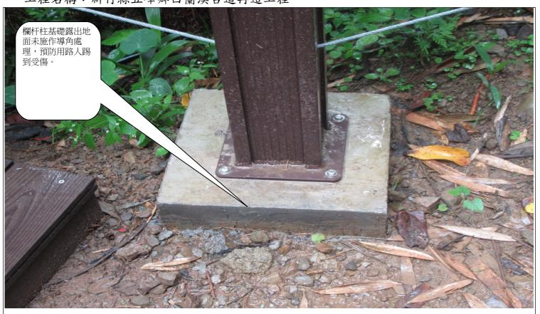
說明欄杆柱基礎露出地面未施作導角處理,預防用路人踢到受傷。
