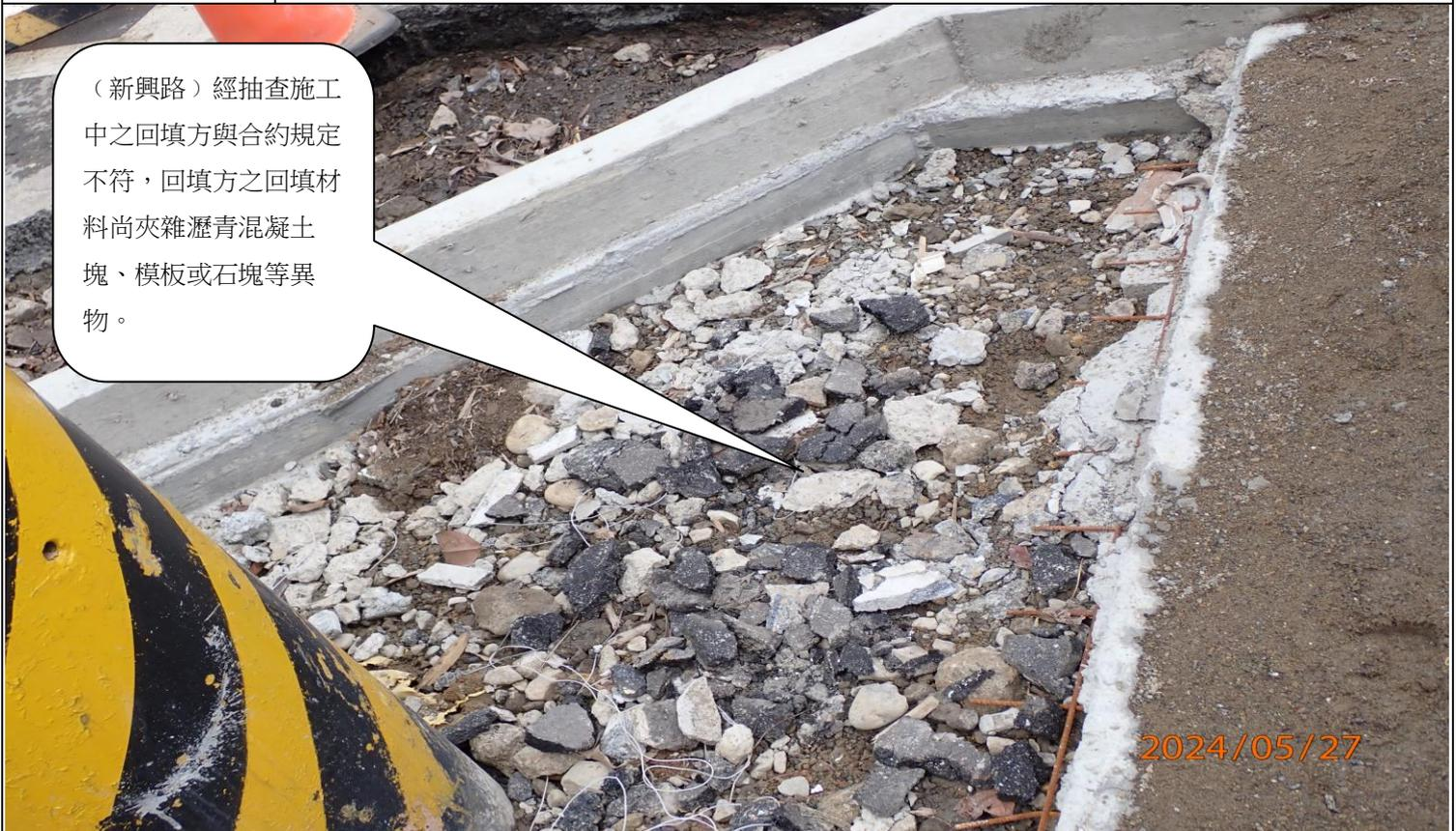
(新興路)經抽查施工中之回填方與合約規定不符，回填方之回填材料尚夾雜瀝青混凝土塊、模板或石塊等異物。
