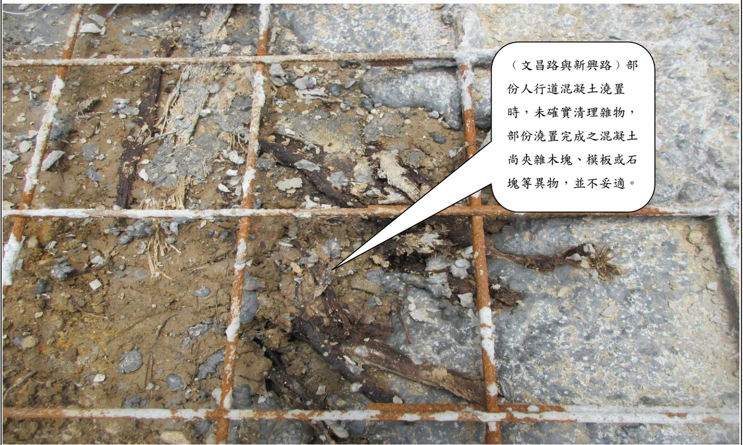
(文昌路與新興路)部份人行道混凝土澆置時，未確實清理雜物，部份澆置完成之混凝土尚夾雜木塊、模板或石塊等異物，並不妥適。
