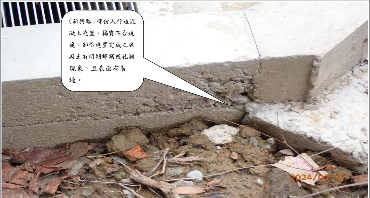
(新興路)部份人行道混凝土澆置、搗實不合規範。部份澆置完成之混凝土有明顯蜂窩或孔洞現象，且表面有裂縫。
