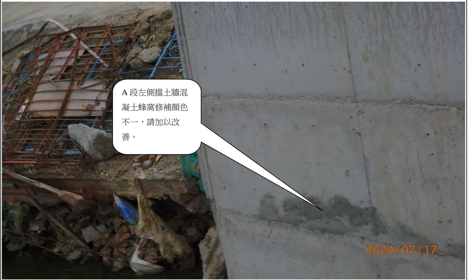
A 段左側擋土牆混凝土蜂窩修補顏色不一，請加以改善。
