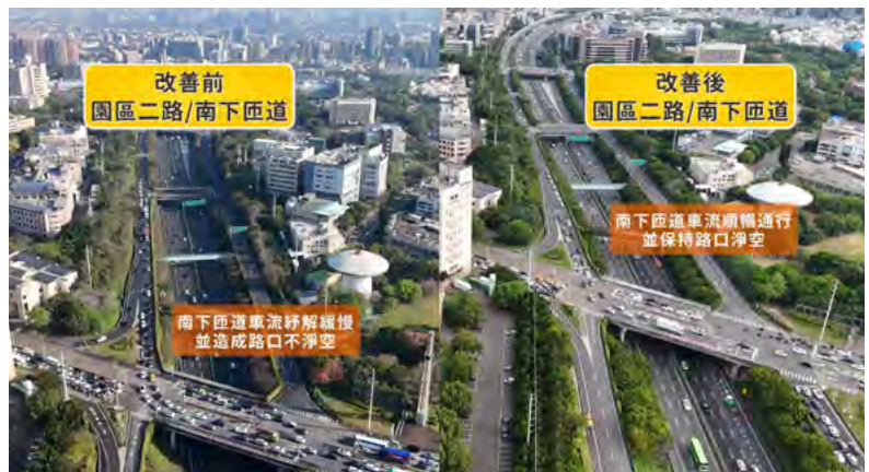
▲ 竹科園區園區二路南下匝道
