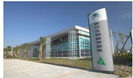
園區生技標準廠房，預期於 100 初完成
