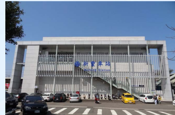
台鐵於縣內新豐跨站工程完工
