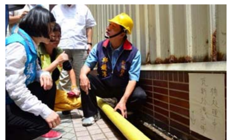
8/18邱縣長視察竹北瓦斯管線維修工程
