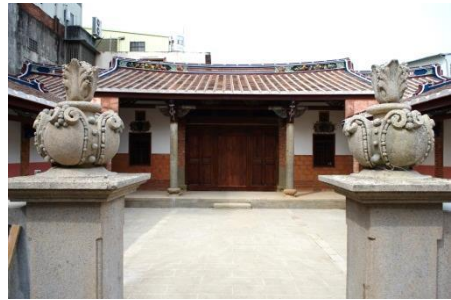
105/2/29 北埔忠恕堂修復工程完工
