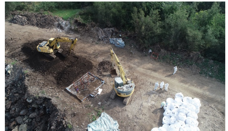
新豐海岸線有害廢棄物移除
