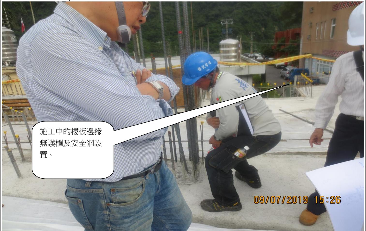
施工中的樓板邊緣無護欄及安全網設置。
