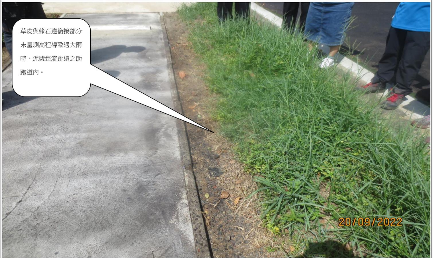
草皮與緣石邊銜接部分未量測高程導致遇大雨時，泥漿逕流跳遠之助跑道內。
