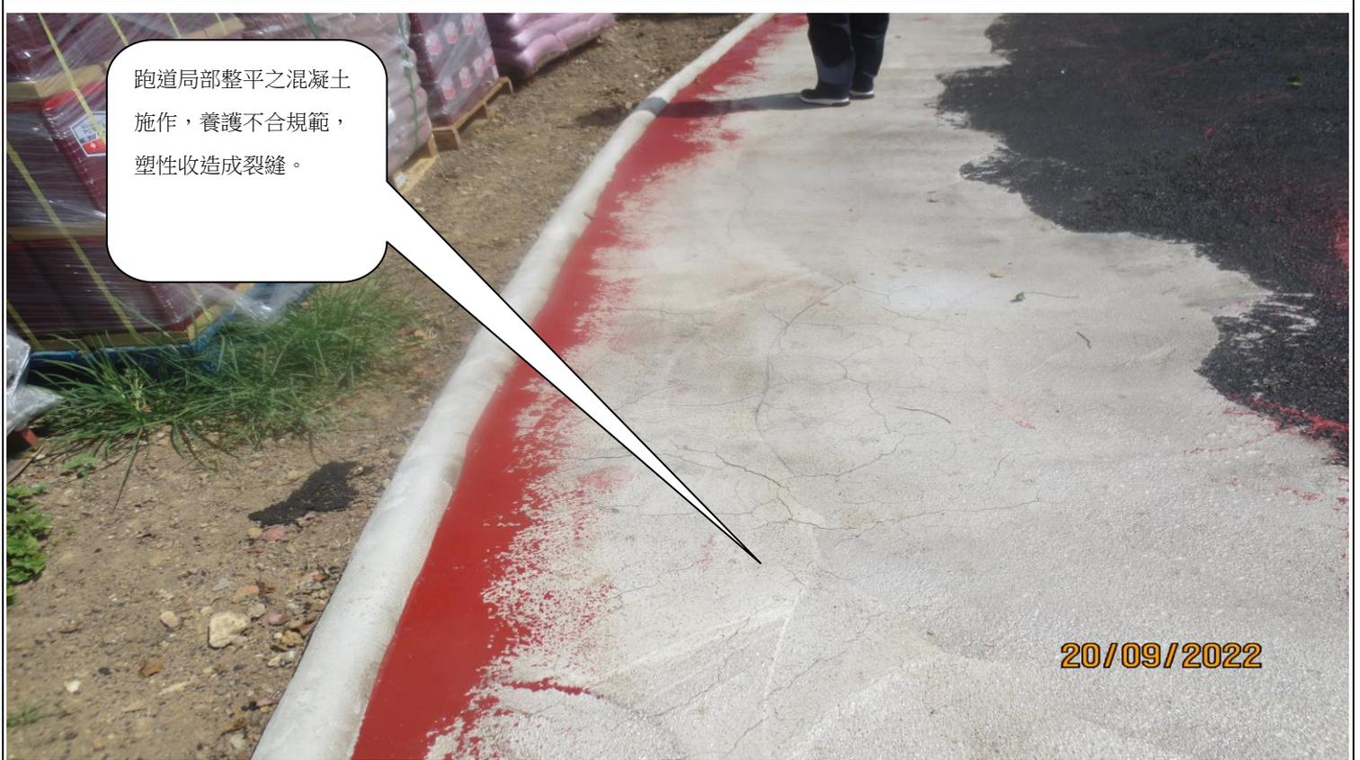
跑道局部整平之混凝土施作，養護不合規範，塑性收造成裂縫。
