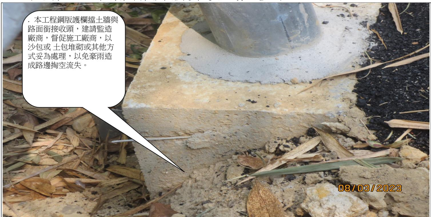
本工程鋼版護欄擋土牆與路面銜接收頭，建請監造廠商，督促施工廠商，以沙包或土包堆砌或其他方式妥為處理，以免豪雨造成路邊掏空流失。
