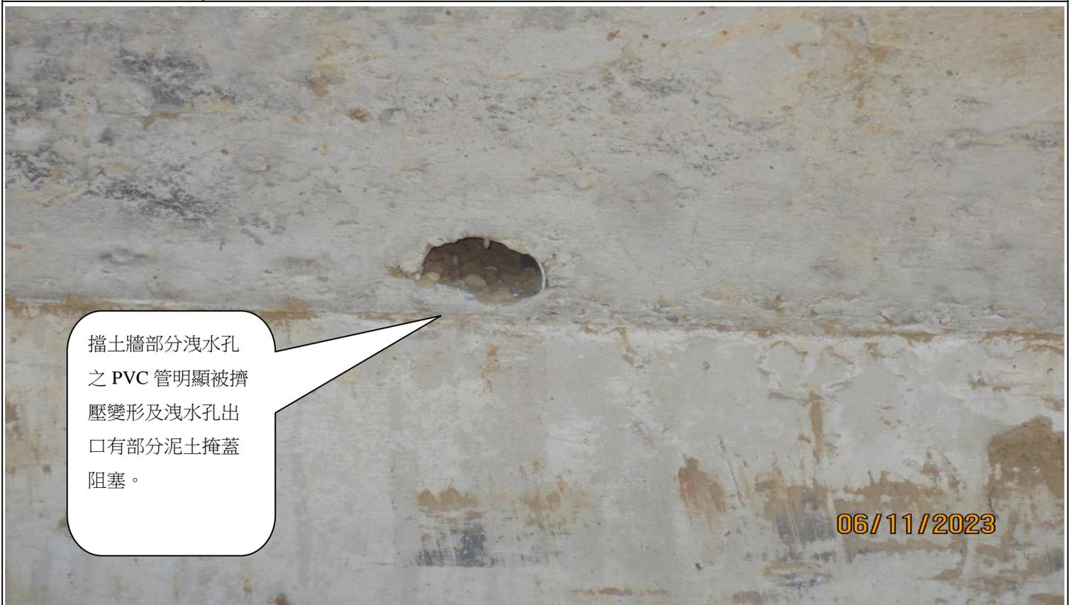
擋土牆部分洩水孔之 PVC 管明顯被擠壓變形及洩水孔出口有部分泥土掩蓋阻塞。
