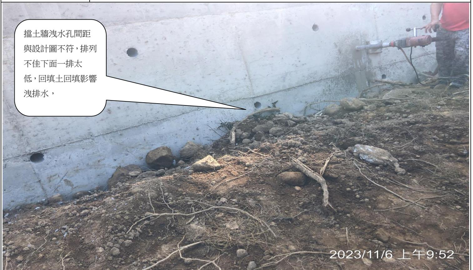
擋土牆洩水孔間距與設計圖不符，排列不佳下面一排太低，回填土回填影響洩排水，
