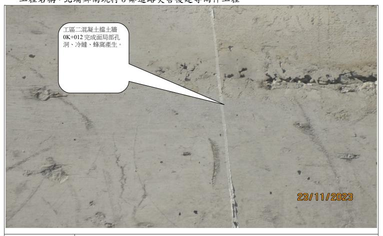
說明 工區二混凝土擋土牆 OK+012 完成面局部孔洞、冷縫、蜂窩產生。
