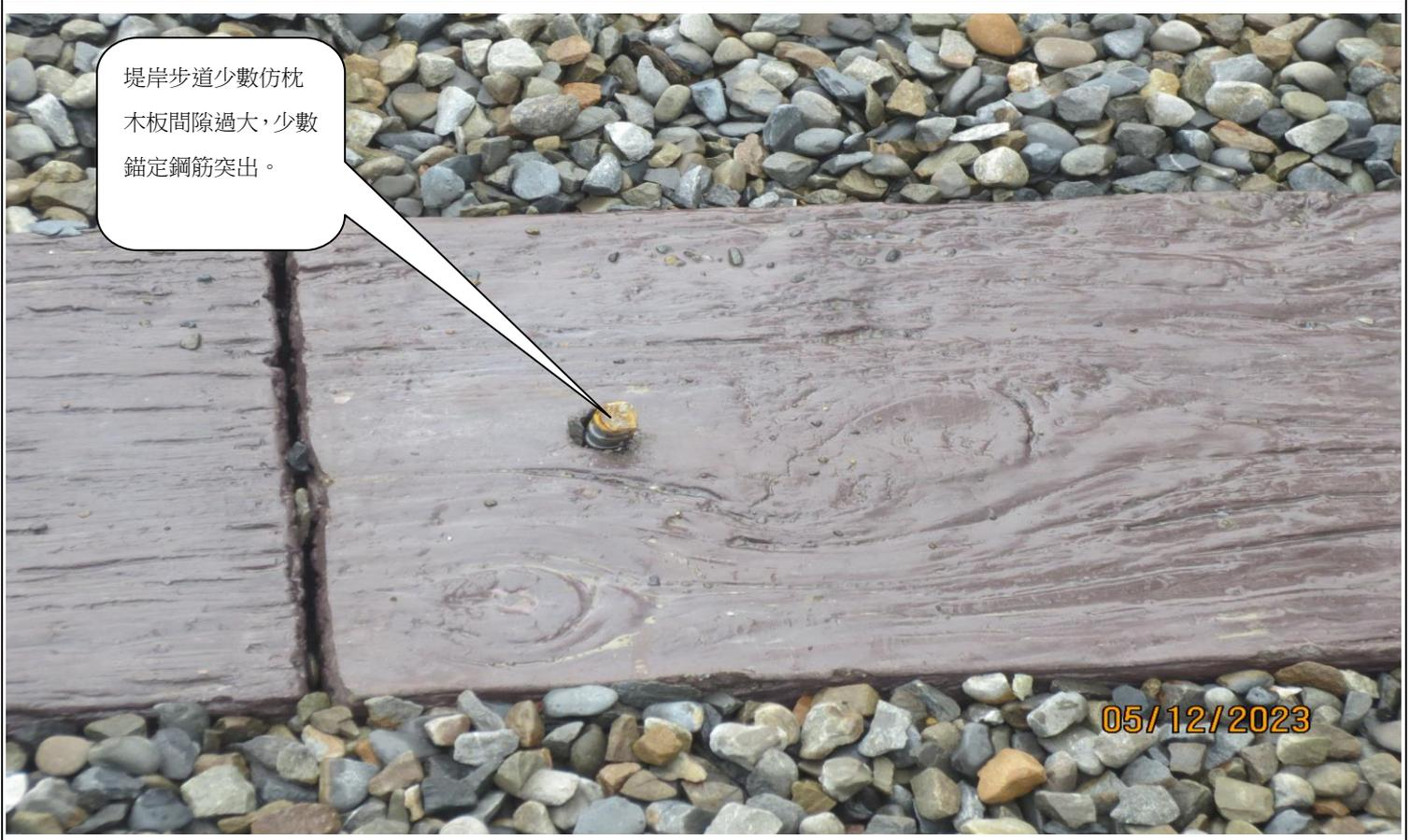
堤岸步道少數仿枕木板間隙過大，少數錨定鋼筋突出。
