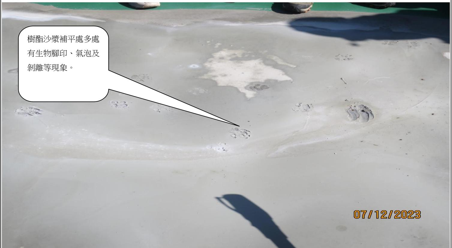
樹脂沙漿補平處多處有生物腳印、氣泡及剝離等現象。
