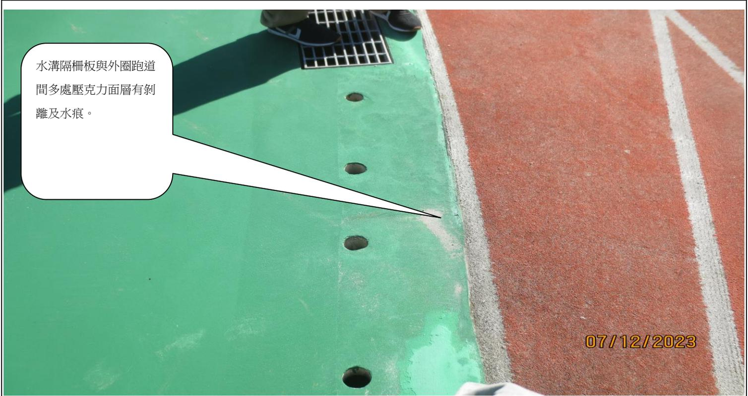
水溝隔柵板與外圈跑道間多處壓克力面層有剝離及水痕。
