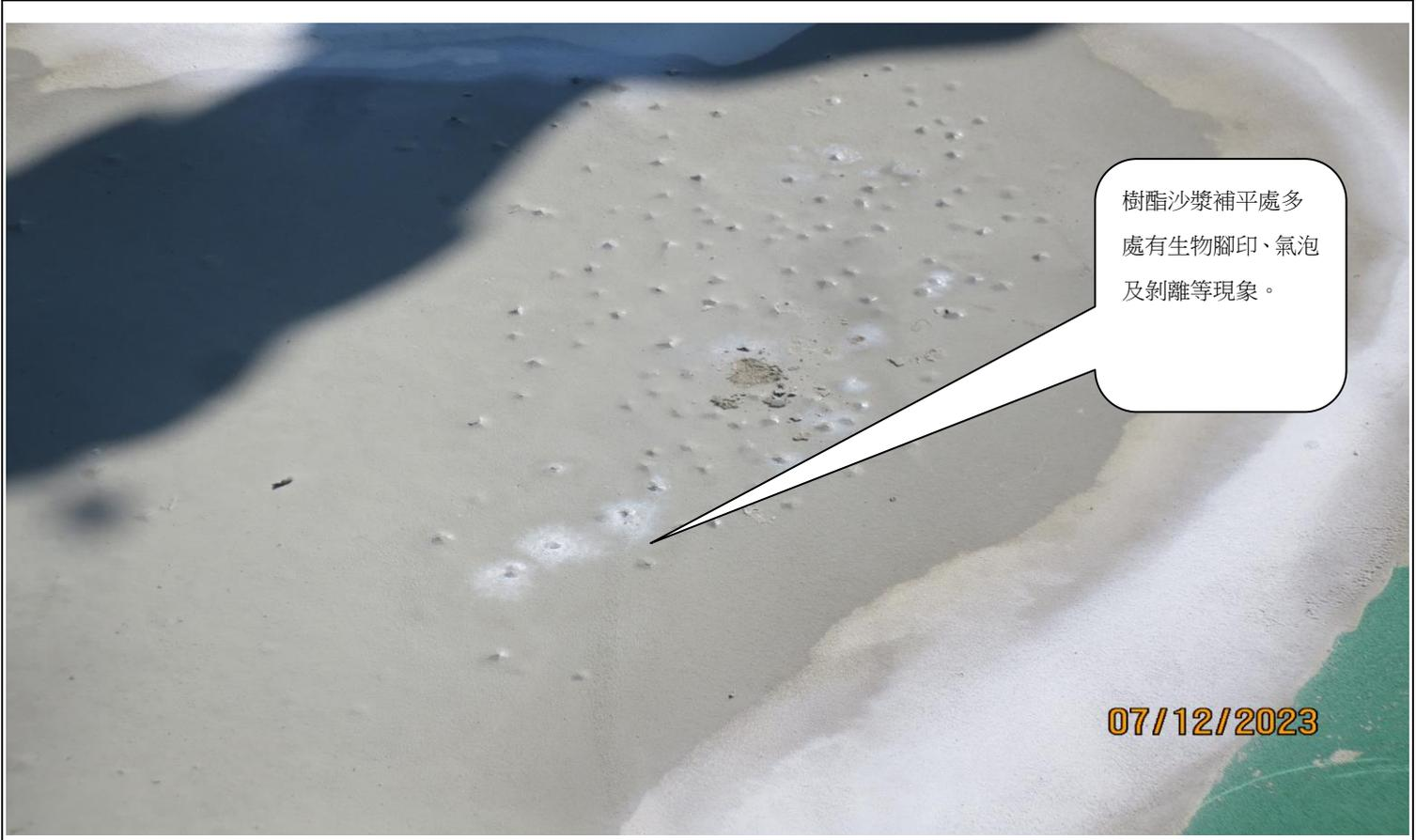
樹脂沙漿補平處多處有生物腳印、氣泡及剝離等現象。
