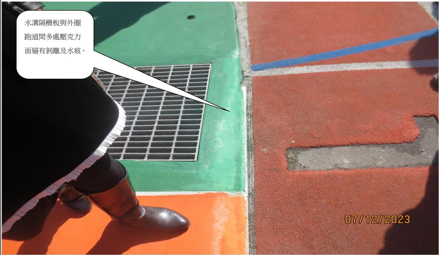
水溝隔柵板與外圈跑道間多處壓克力面層有剝離及水痕。
