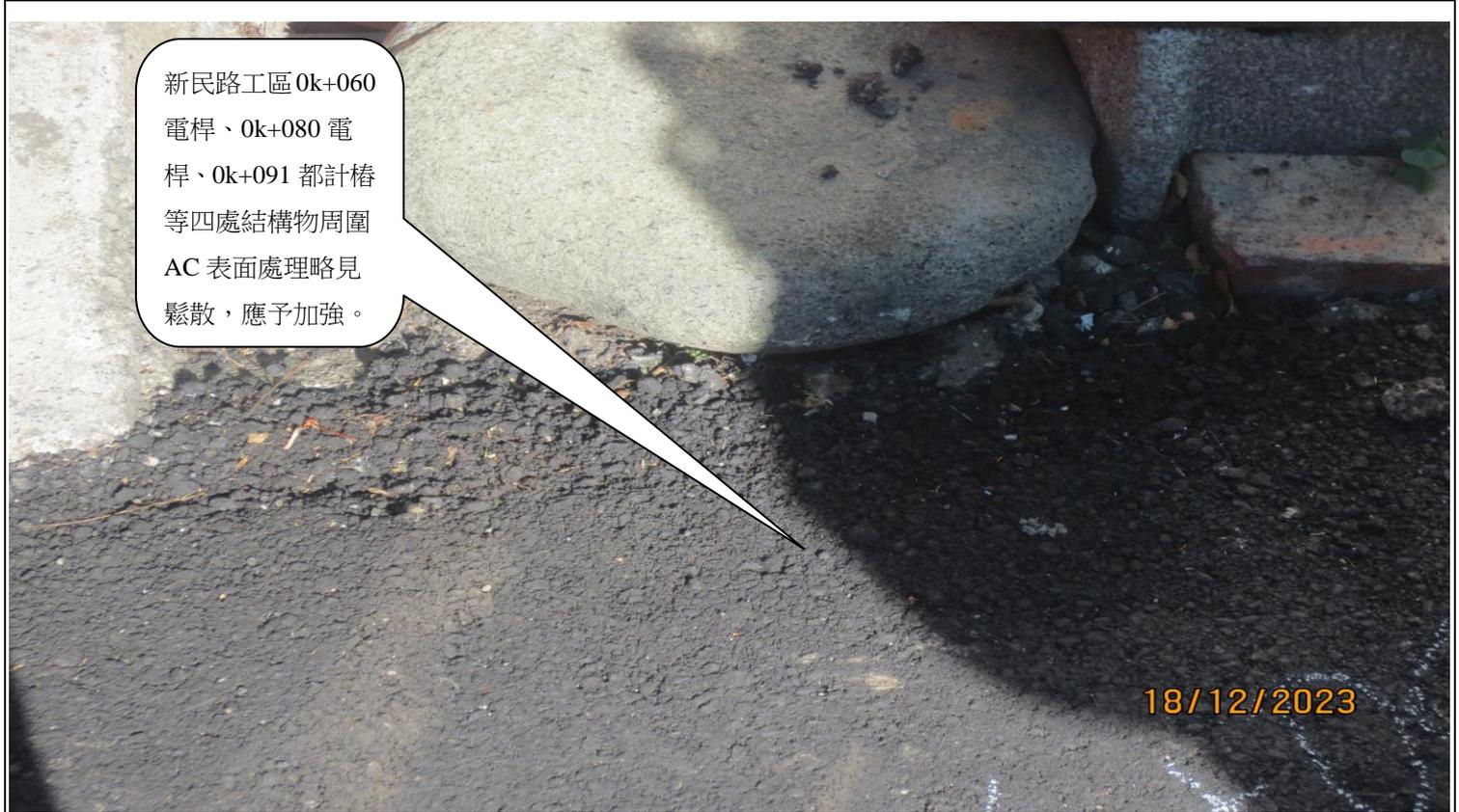
新民路工區 0k+060 電桿、0k+080 電桿、0k+091 都計樁等四處結構物周圍 AC 表面處理略見鬆散，應予加強。
