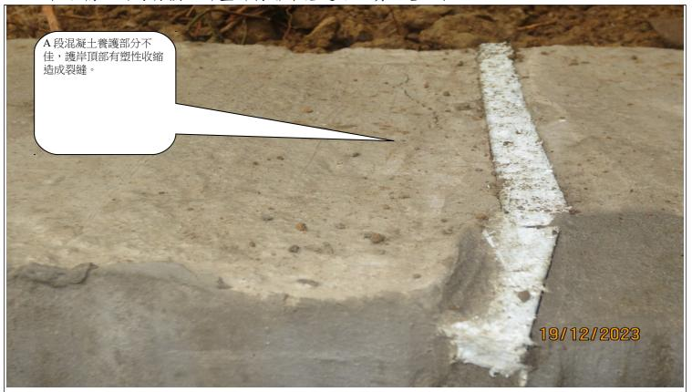
說明 A 段混凝土養護部分不佳,護岸頂部有塑性收縮造成裂縫。
