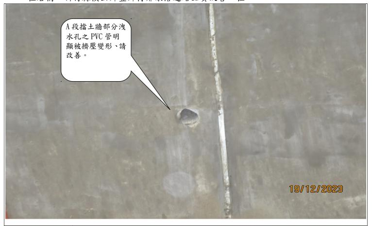
說明 A 段擋土牆部分洩水孔之 PVC 管明顯被擠壓變形、請改善。
