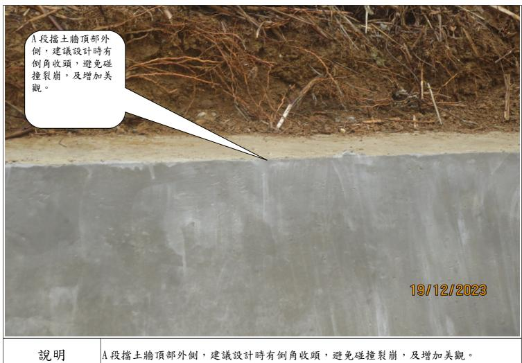
A段擋土牆頂部外側,建議設計時有倒角收頭,避免碰撞裂崩,及增加美觀。
