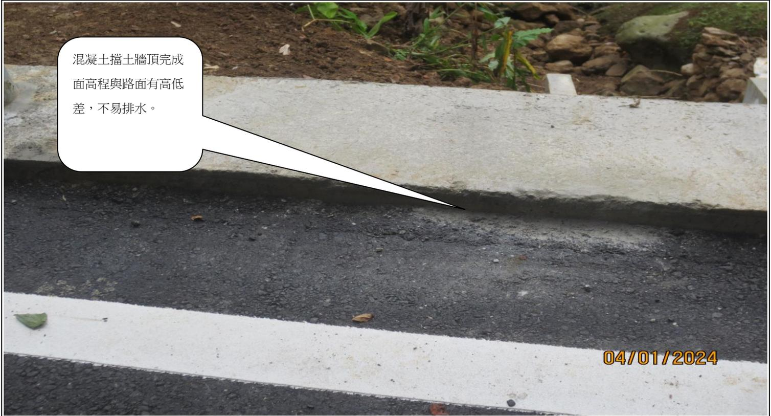
混凝土擋土牆頂完成面高程與路面有高低差，不易排水。
