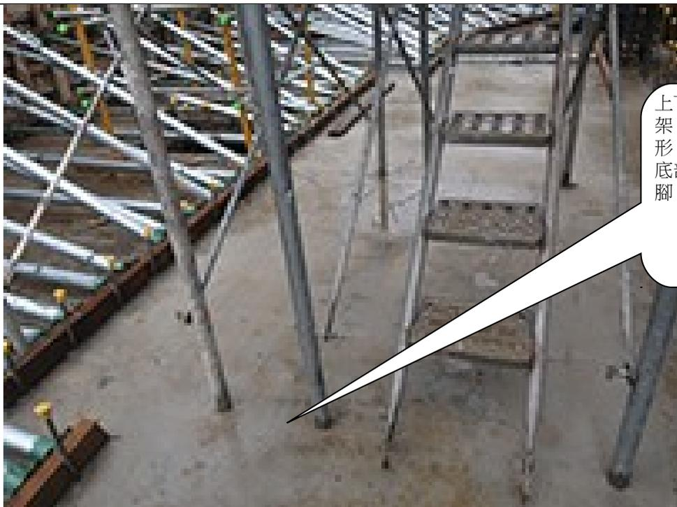
上下設備之施工架，尚有不足情形，例如：施工架底部，未設調整腳。
