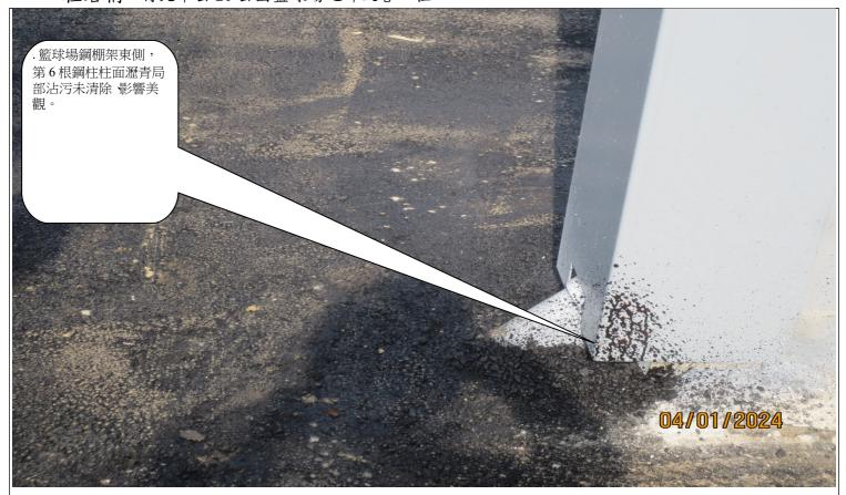
說明. 藍球場鋼棚架東側,第6根鋼柱柱面瀝青局部沾污未清除、影響美觀。
