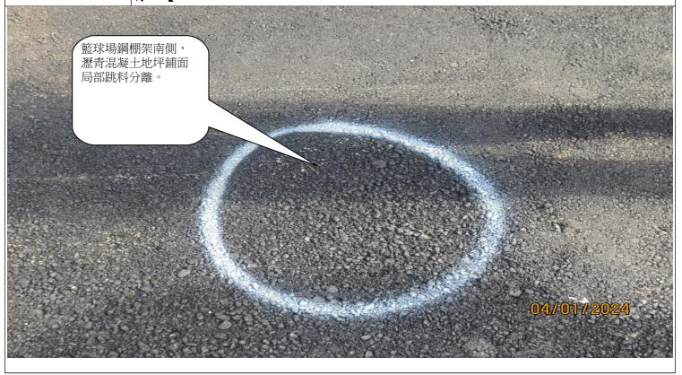
籃球場鋼棚架南側,瀝青混凝土地坪鋪面局部跳料分離。
