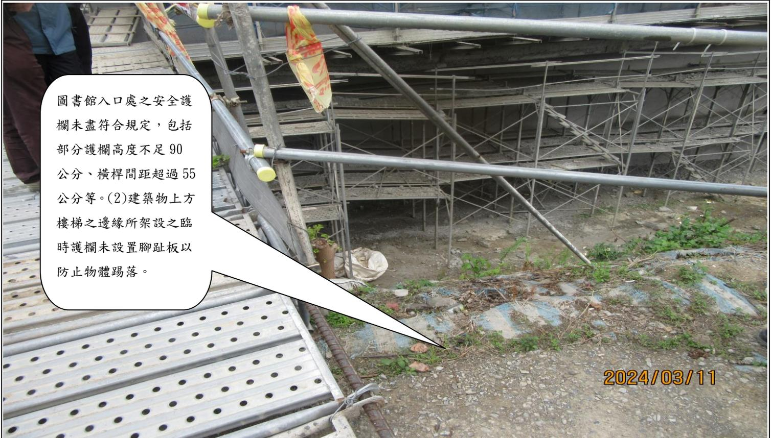
圖書館入口處之安全護欄未盡符合規定，包括部分護欄高度不足 90 公分、橫桿間距超過 55 公分等。(2)建築物上方樓梯之邊緣所架設之臨時護欄未設置腳趾板以防止物體踢落。
