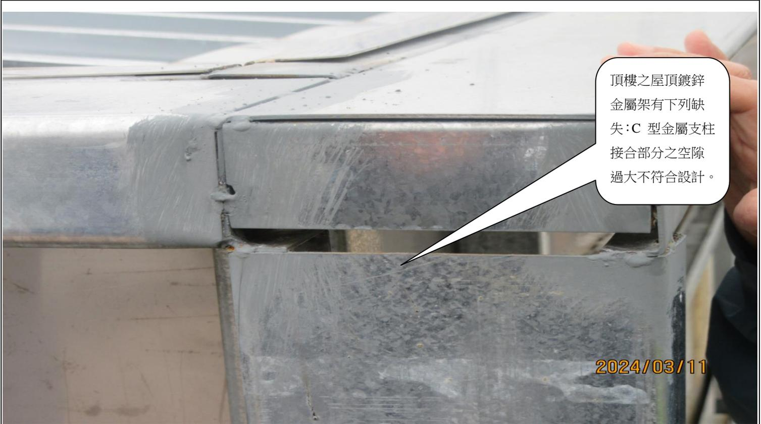
頂樓之屋頂鍍鋅金屬架有下列缺失：C 型金屬支柱接合部分之空隙過大不符合設計。
