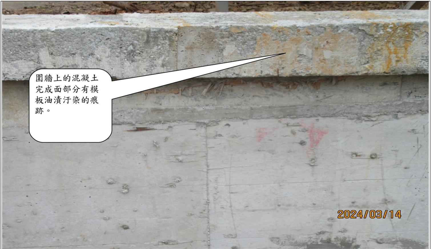
圍牆上的混凝土完成面部分有模板油漬污染的痕跡。
