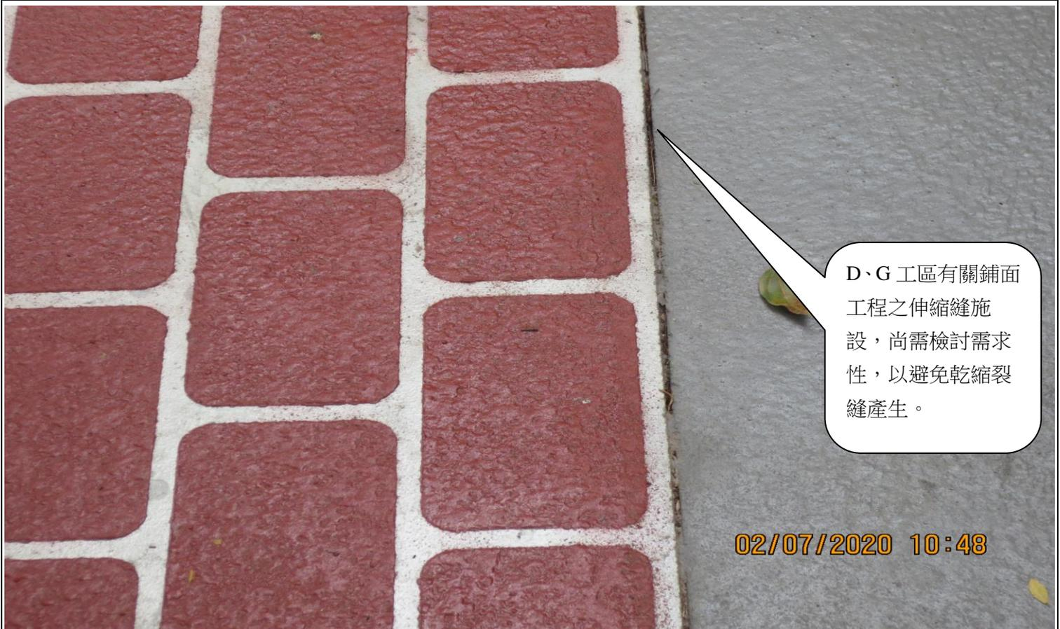
D、G 工區有關鋪面工程之伸縮縫施設，尚需檢討需求性，以避免乾縮裂縫產生。
