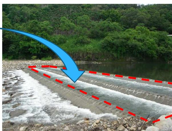
將臨時圍水設施拆除破碎後，置入消能池，作為人工魚礁，以減少混凝土運棄，達到節能減碳之功效，並提供魚群棲息之空間，兼具生態保育之功效。
