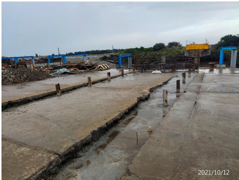
牛埔溪出海口:A4 橋台及擋土牆施工
