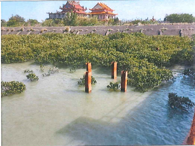
說明：施工構台周邊紅樹林現況良好未受干擾 日期：111/3/9
