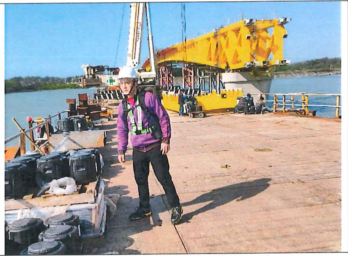
說明：生態人員執行生態檢核作業情形 日期：111/3/9
