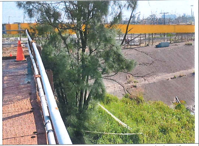
說明：施工構台側邊喬木及植生現況良好未受干擾 日期：111/3/9
