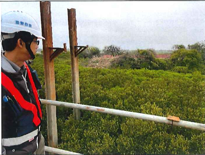
說明：目前施工尚未影響紅樹林區域 日期：110/03/09
