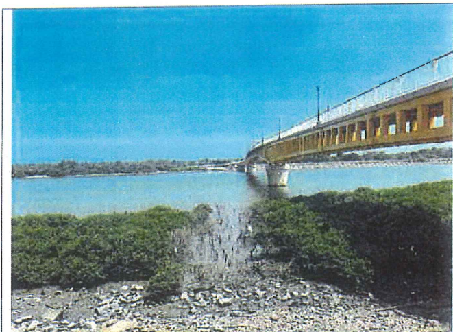
說明：施工構台已拆除，建議後續觀察紅樹林復原情形 日期：111/08/24
