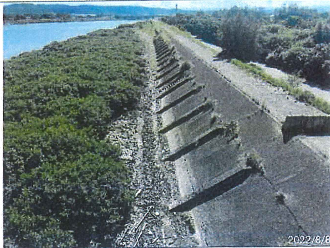
說明：工區周圍海漂廢棄物已清除 日期：111/08/08
