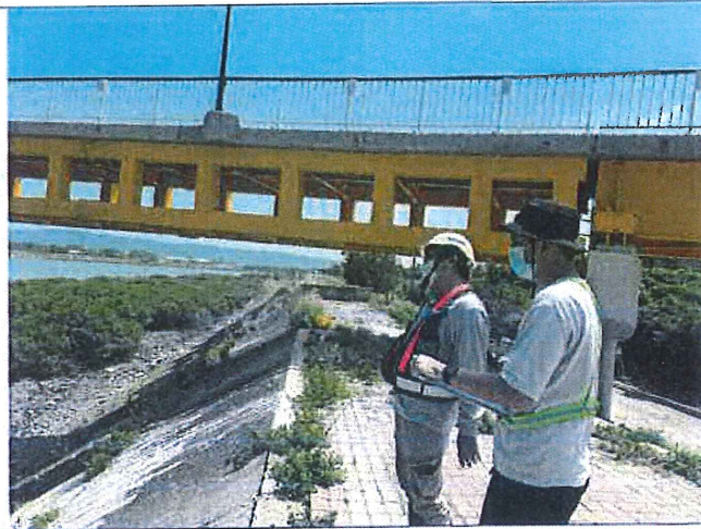
說明：生態人員執行生態檢核作業情形 日期：111/08/24
