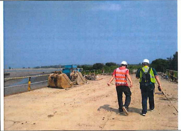
說明：工材及器具確認堆放整齊 日期：110/9/1
