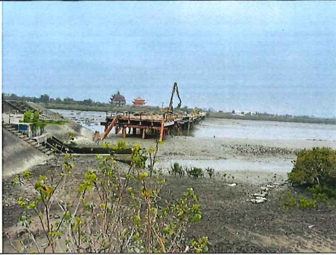
說明：施工已有迴避紅樹林區域 日期：110/03/09
