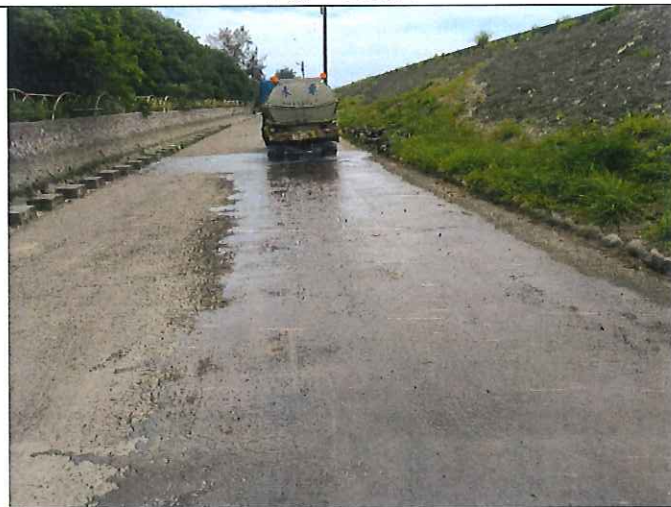
說明：定期灑水降低揚塵 日期：110/9/1
