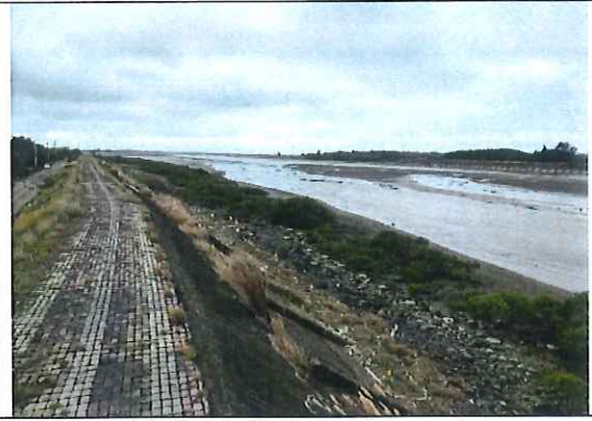
說明：紅樹林現況(未施工) 日期：109/11/6
