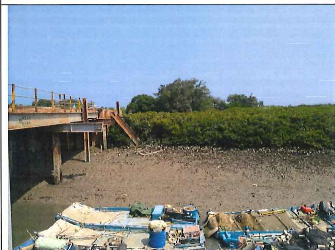
說明：當天水位低，構台未阻隔水流 日期：110/9/1
