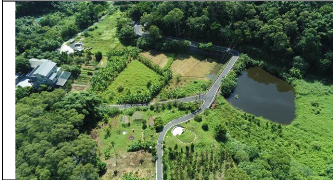
環境照-鄰近區空拍
