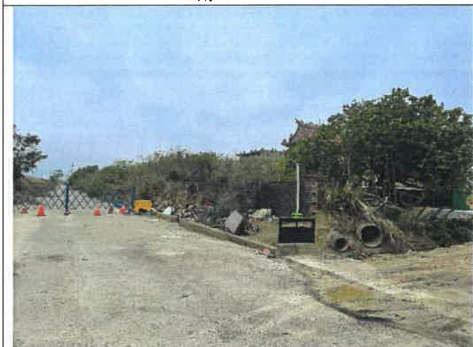
說明：無法避免春冬施工，保留工區內大型樹木，供候鳥棲息及休息，並縮小施工範圍 日期：110/03/09
