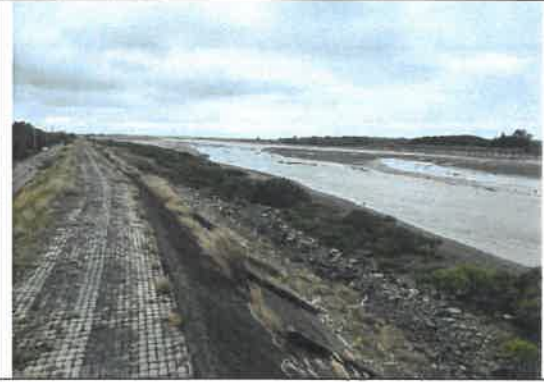
說明：紅樹林現況(未施工) 日期：109/11/6
