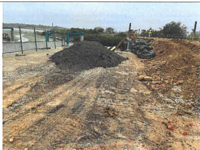
說明：強風來臨建議採用塑膠布覆蓋，平時採用灑水降低揚塵 日期：110/03/09
