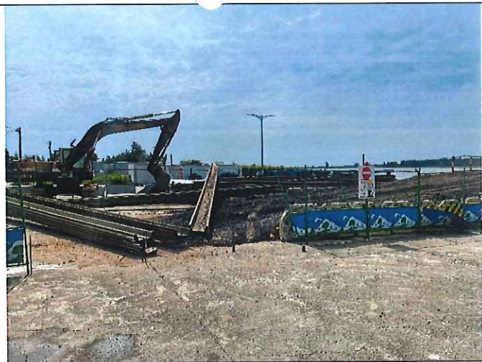
說明：工程機具及材料統一堆放 日期：110/06/01
