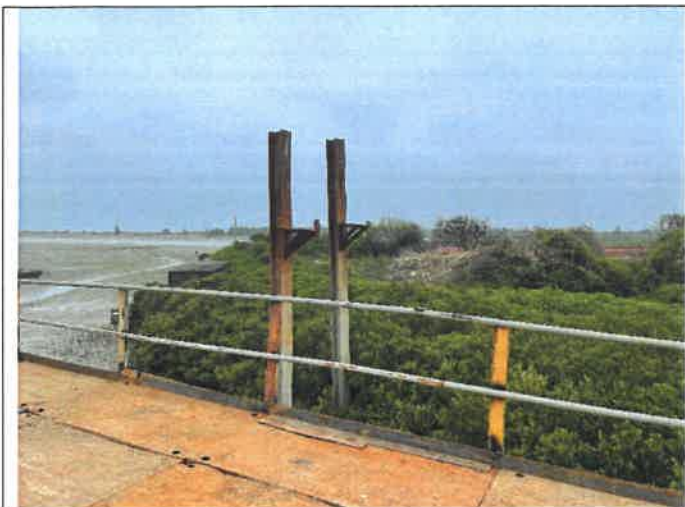
說明：建議明確標示開挖範圍，避免過開挖紅樹林區域 日期：110/03/09
