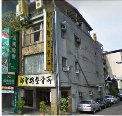
背(側)向立面照片
