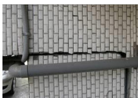
外牆柱斷裂
