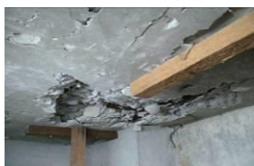
天花板鋼筋外露
